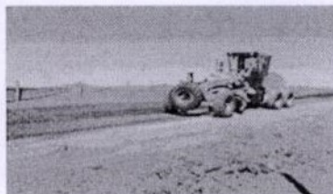
Motorizadora en labor de Recebo con provisión externa de material.
