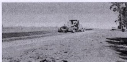
Motorizadora en labor de Reperfilado Simple con Recebo.
