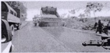
Riego con Emulsión Asfáltica CS2 ( Masilla Asfáltica )
