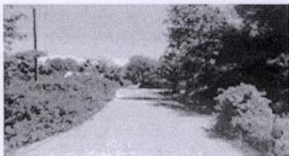
Las Capas de Protección es una solución económica que mejora considerablemente la vida útil al reducir de una vez distribuyéndose al porcentaje de caminos en Tierra.
