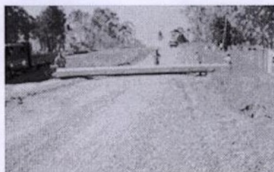
La Operación se refiere a la construcción de Alcantarillas de tubo metal corrugado con el propósito de reparar, reemplazar, alargar o completar las alcantarillas de este mismo material.
